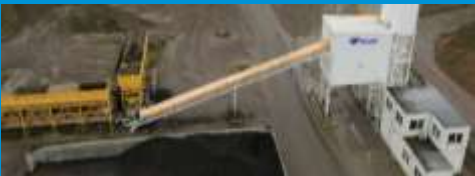
Burcht Betoncentrale, Recyclagecentrum
