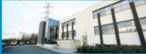
Bilzen Beton- en asfaltcentrale, recyclagecentrum
